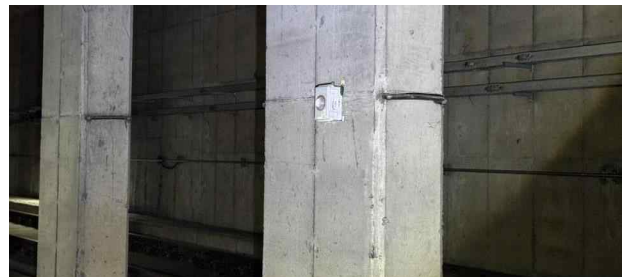
<경보장치 송신기 설치>
