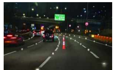
도로표지병 보완 시공
