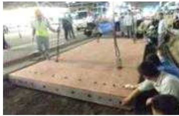
현장 조립 시공
