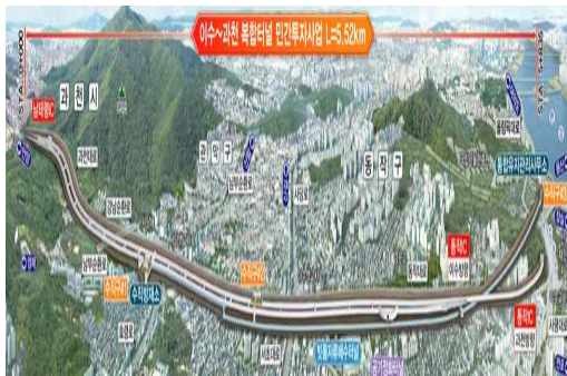
〈이수~과천 복합터널 건설〉
