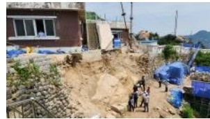
[붕괴구간 공사] ▲ 인왕곡성
