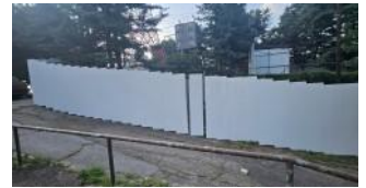
[위험구간 공사] ▲ 남산
