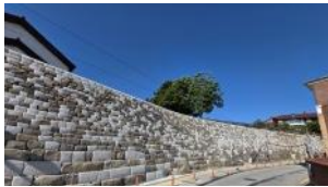
[위험구간 공사] ▲ 혜화동
