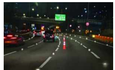
〈도로표지병 보완 시공〉
