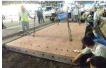
〈현장 조립 시공〉
