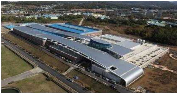
<입상활성탄지 외부 전경>
