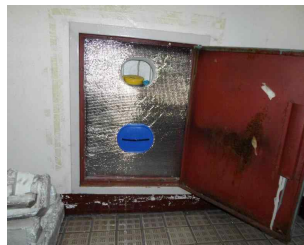
<벽체형 PE보온재> (계량기함 내부 설치)
