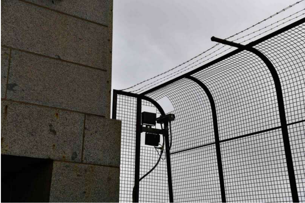
철탑 전망대 입구 CCTV
