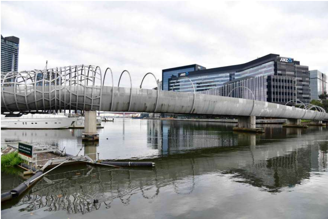
웹 브릿지 곡선 경사로 및 기존 교량 연결부
