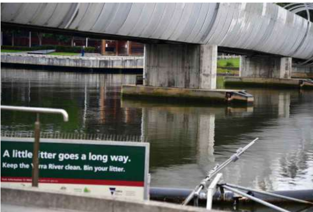
⑤ 웹 브릿지 기존 교량 교각부
