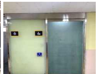
< 체육시설 무장애(자동문 설치) >
