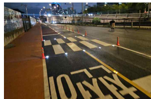
<LED 표지병 설치>
