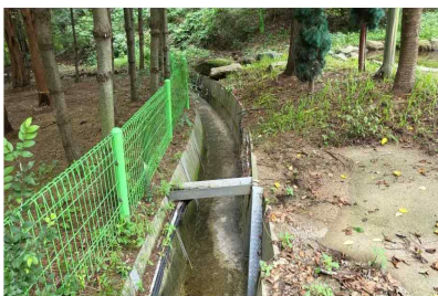
배수로 준설 및 정비 상태 확인
