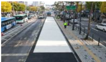
고강성 콘크리트 포장
