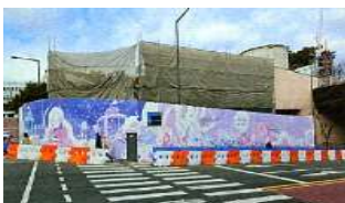
<곤돌라 설치공사 현장>
