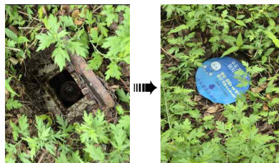
<계량기 위치표식 설치>
