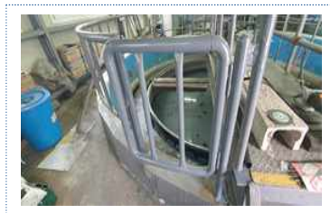
【폐수처리장 안전난간 보강】
