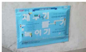
[계량기함 보온덮개] (계량기함 외부 밀폐)
