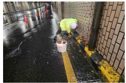
〈증산지하차도 배수로 청소〉
