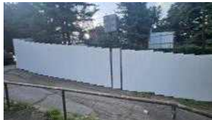
[위험구간 공사] ▲ 남산
