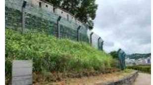
[낙산 낙석방지책 설치]
