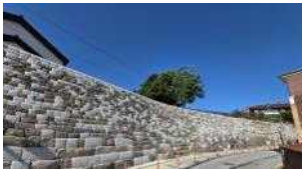
[위험구간 공사] ▲ 혜화동
