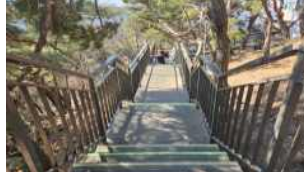
[백악 우회 탐방로 설치]
