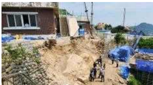
[붕괴구간 공사] ▲ 인왕곡성
